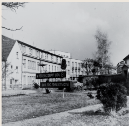
Při adaptaci v letech 1958 až 1959 byla začleněna stará budova lázní do nového komplexu a splynula s ním k nepoznání.
